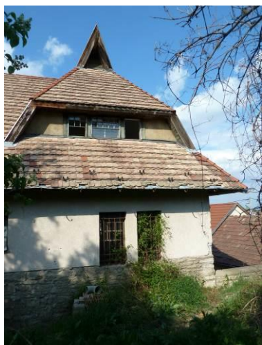
Marschalkó villa – oldal homlokzat
